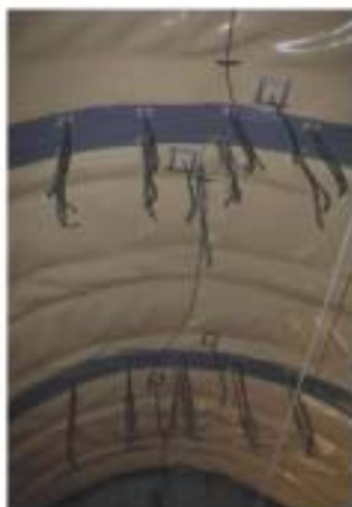
Foto: Entlüftungsleitungen eingebaut, NBS Köln – Rhein/Main
